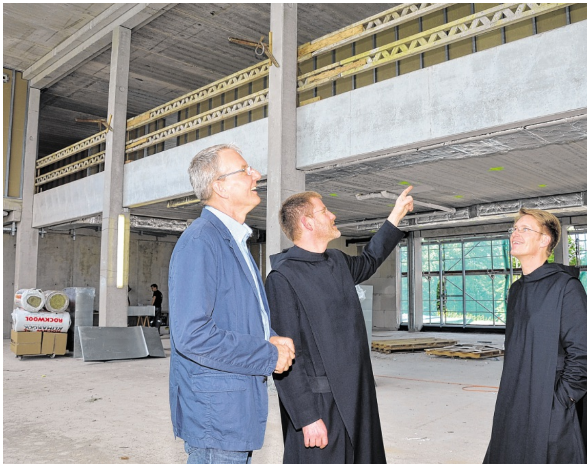
Heinz Plugge (Schulleiter), Pater Abraham (Prior und Baubeauftragter des Klosters), Pater Julian (Vertreter des Schulträgers und Baubeauftragter der Schule) im Rohbau der neuen Mensa (von links).
